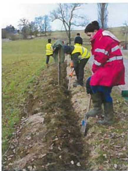
Les lycéens creusent la tranchée qui recevra le filet de protection.
